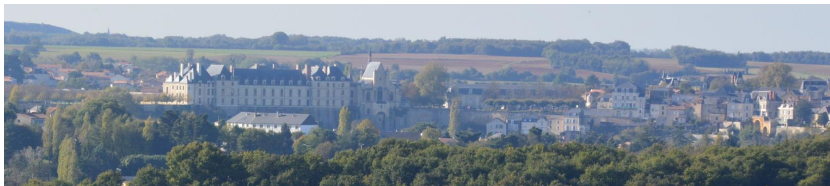
Vue sur le château et la silhouette ancienne de la ville – Source : AVAP de Thouars
