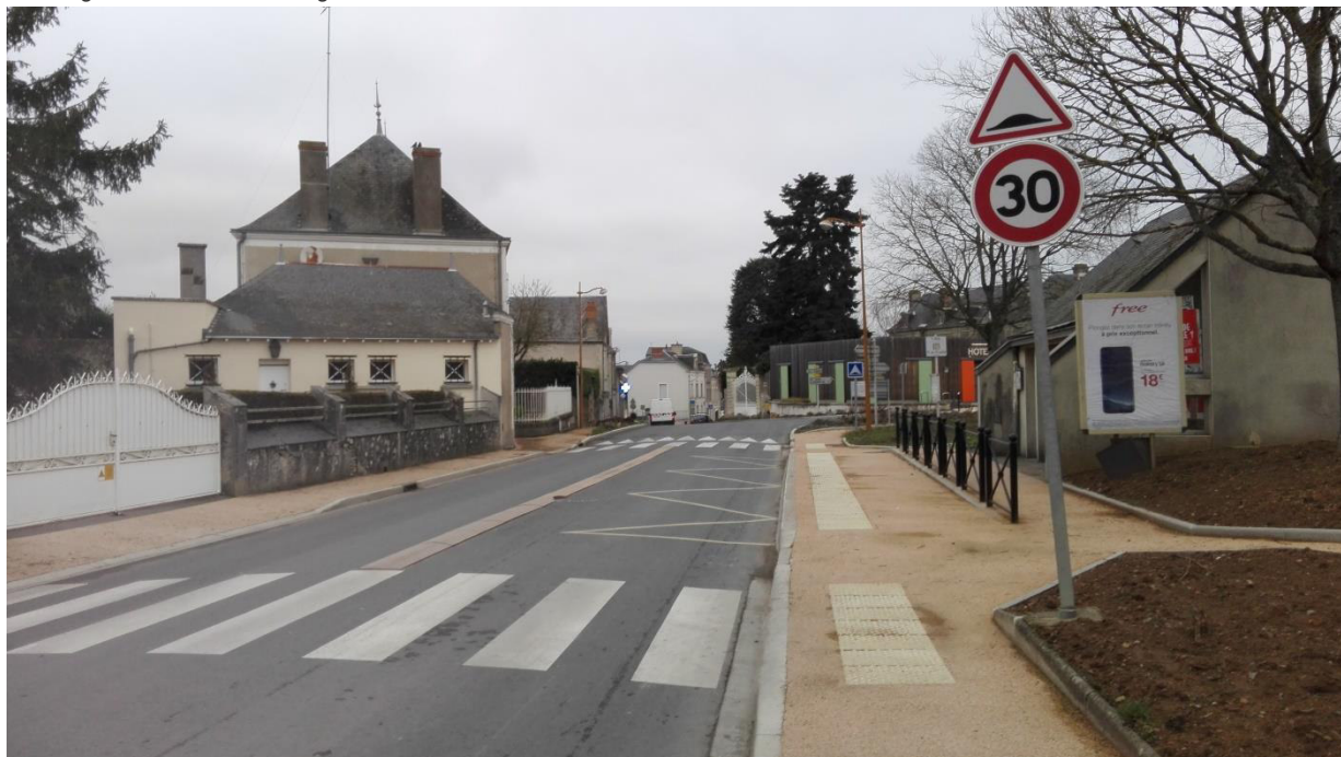
Aménagement du centre-bourg de Saint-Varent en zone 30
